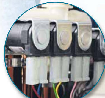
Ventilblock für optimale Wasserverteilung
